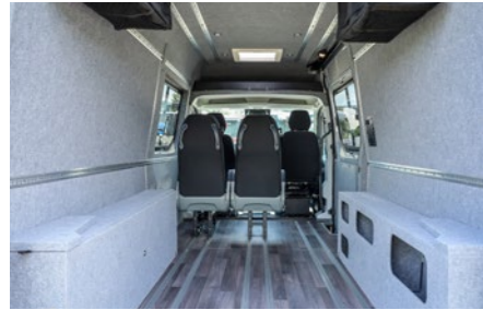
Wand- und Deckenverkleidung inkl. Schall-/Wärmedämmung des kompletten Fahrzeuginnenraums mit AluButyl und 40 mm Armaflex.
